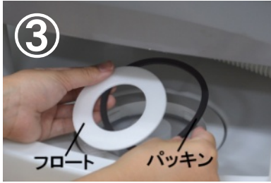
③「フロート」と「平パッキン」を取り外します。
