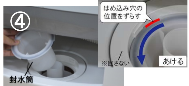
④「封水筒」を矢印の方向に回し外します。
