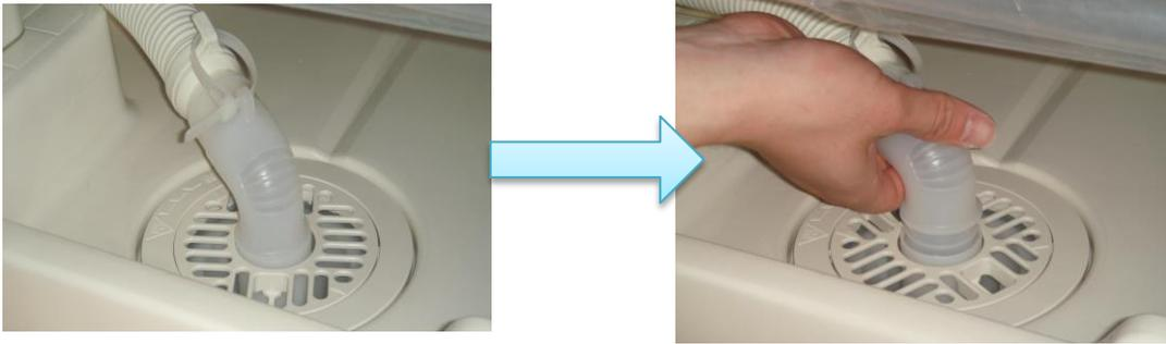
②目皿穴に指をいれ矢印の方向に回して「目皿」をはずします。
