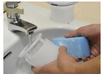
⑥お掃除が終わったら、「ワン」→「消泡筒」→「封水筒」の順に入れ、「封水筒」をしっかりと締め付けます。
