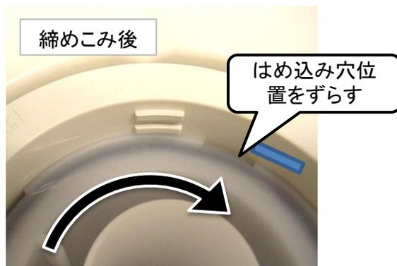
封水筒の締め付け確認
